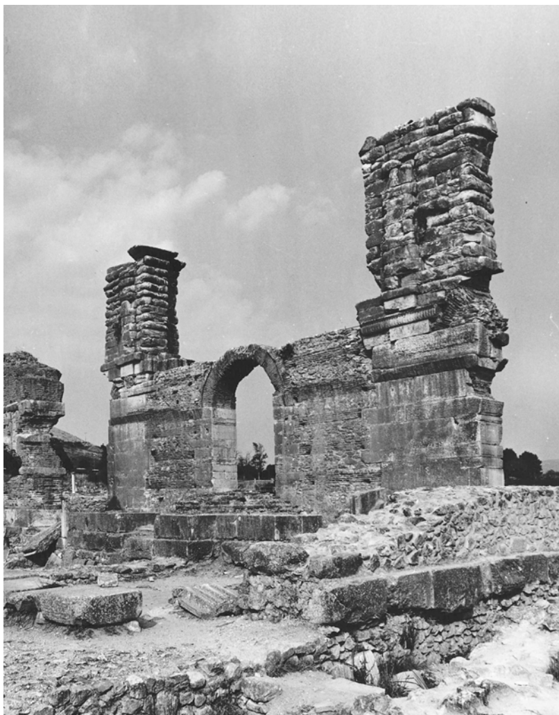
Възстановителни работи по Базилика В Колоните с капителите още не са изработени и донесени Фотоснимка А. Чилинзирев, юни 1978 г.
