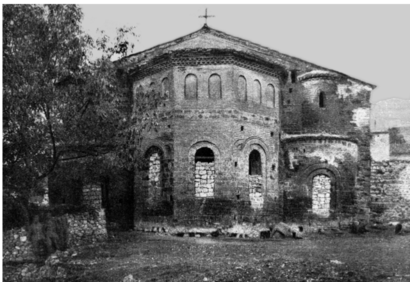
Изглед от изток
