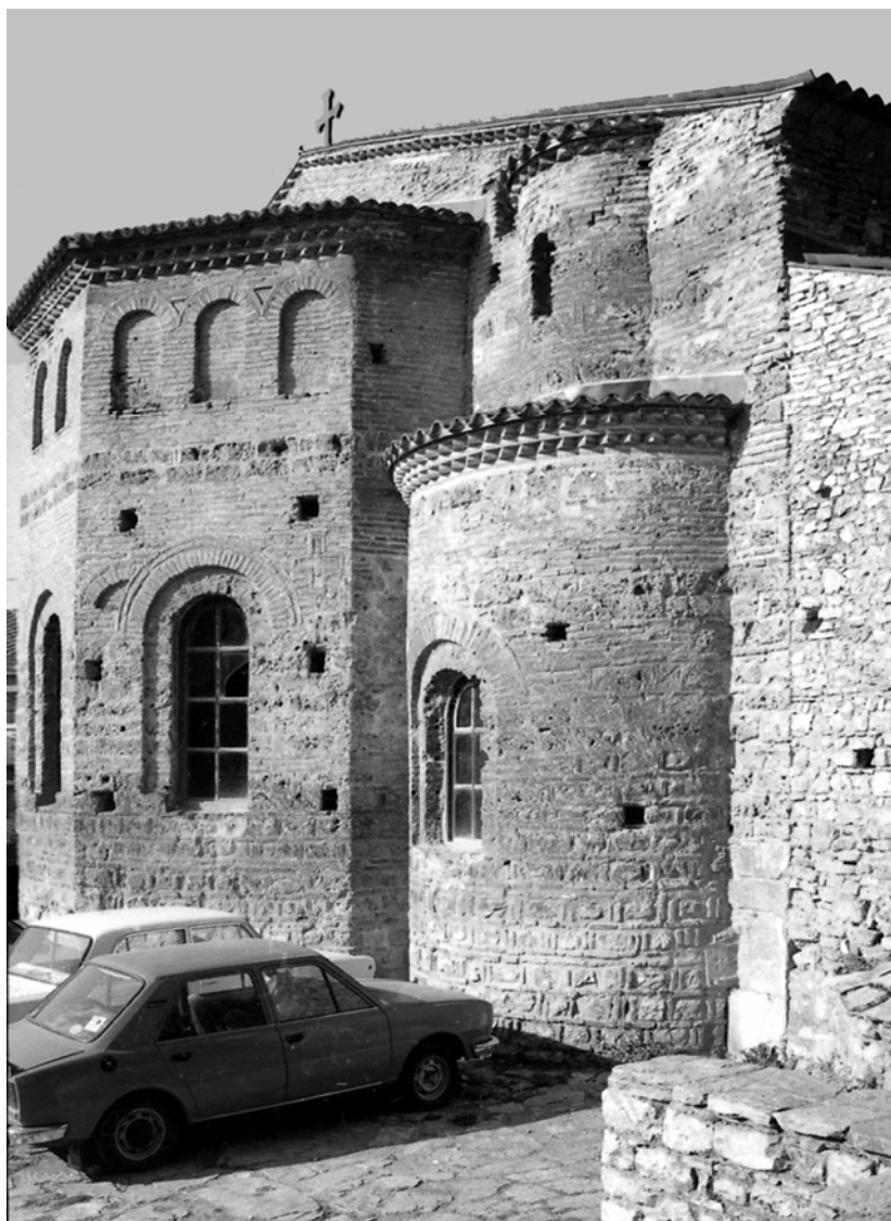
Охрид, „Света София“ Част от източната фасада Фотоснимка 1999 година
