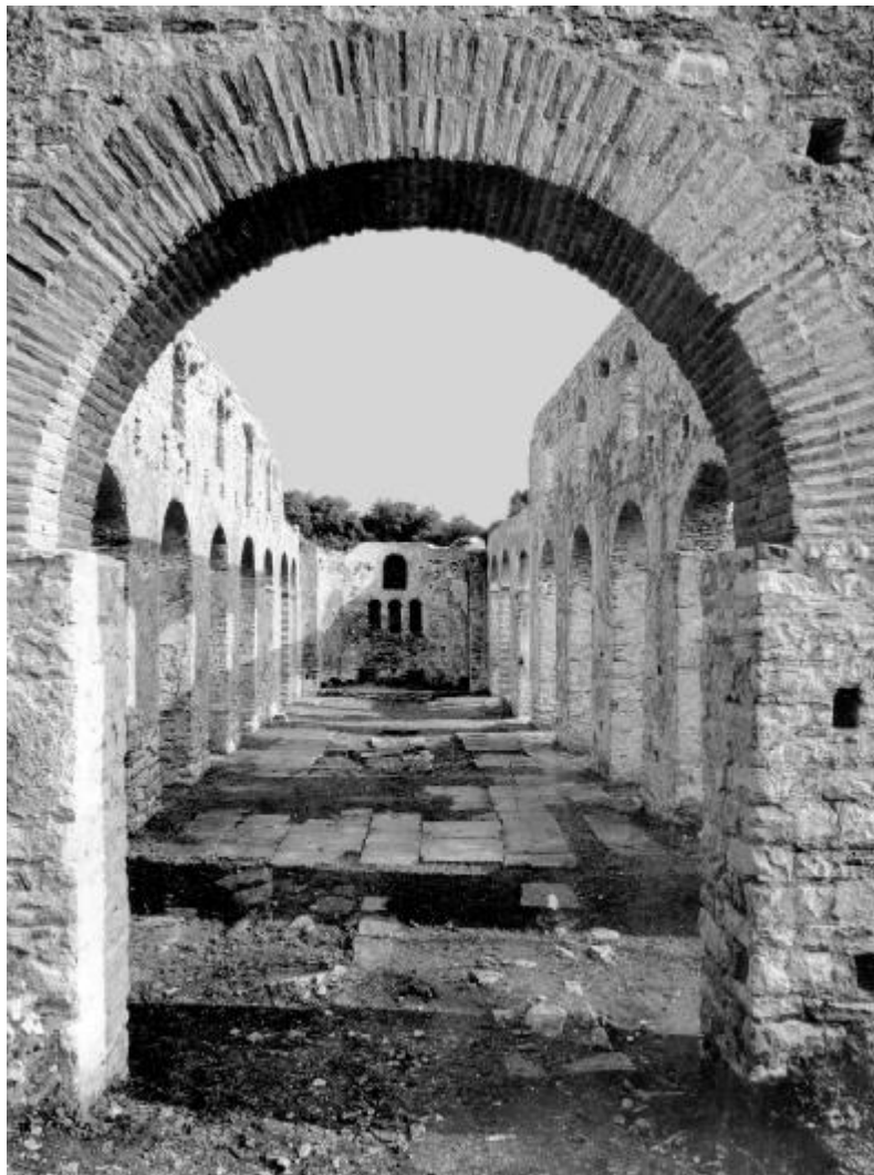
Бутринт, Голямата базилика Изглед на средния кораб от запад (снимка ноември 1986)
