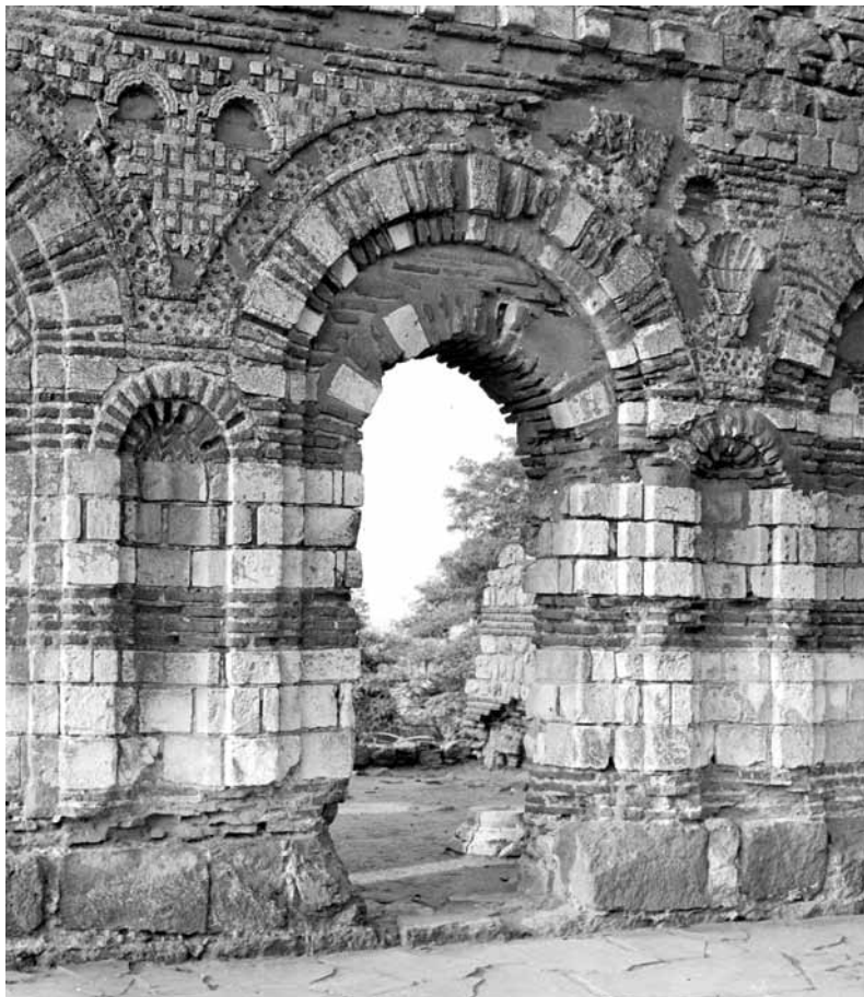
Детайл от северната стена
